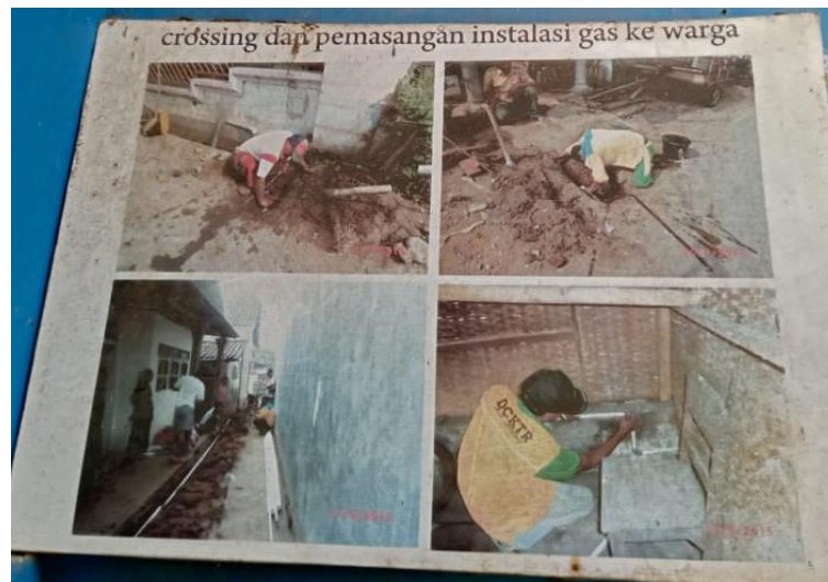
Gambar 5. Crossing dan Pemasangan Instalasi Gas ke Warga
